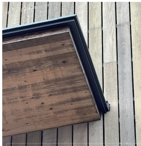
図5 高知学園大学8号館 CLT 現しの庇と2重の水切り
